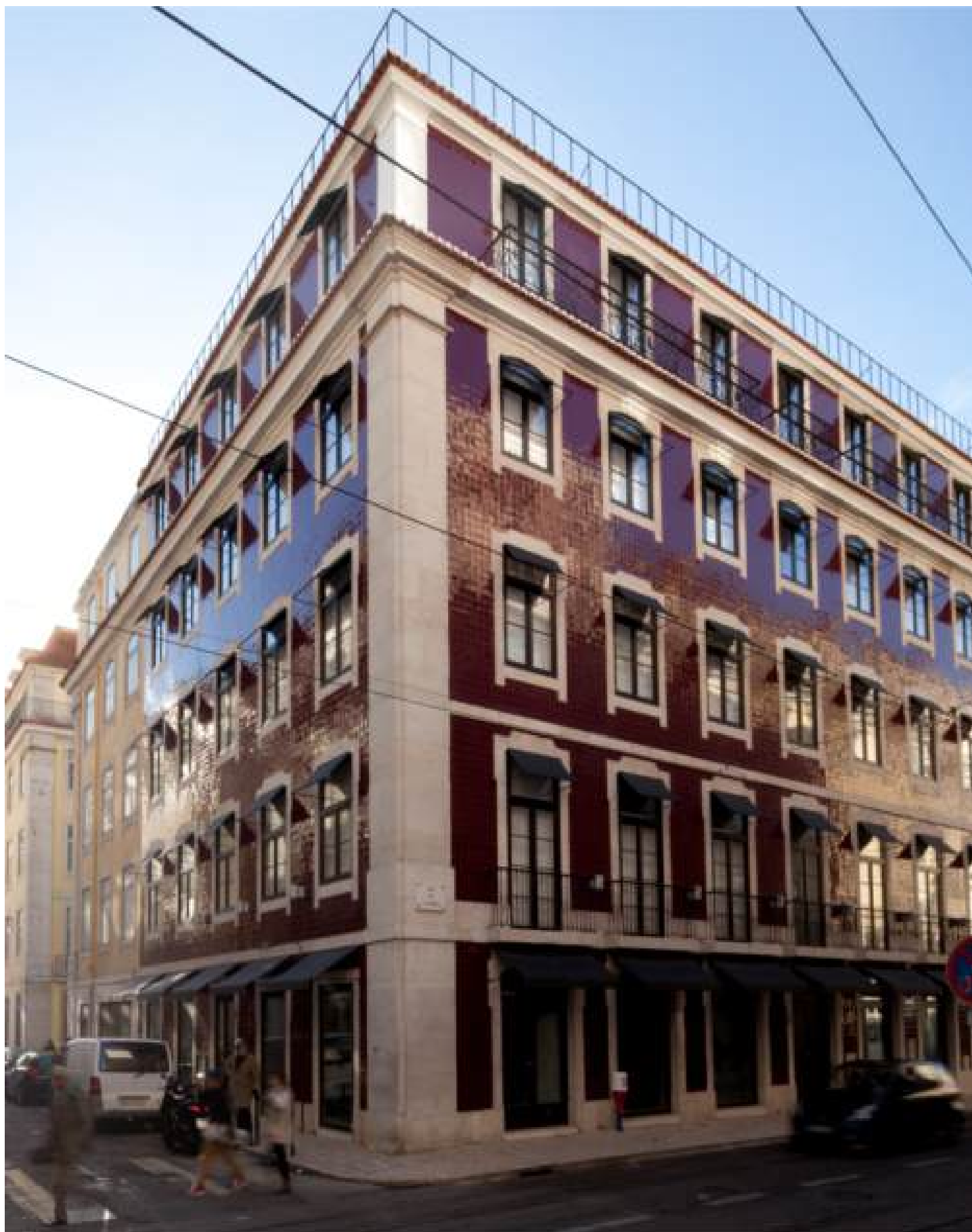
Arq.º Luis Rebelo de Andrade - edifício habitacional, Rua de S. Paulo 55, Lisboa . azulejo semi-manual 14x14cm, cor F27 Créditos Fotográficos: FG+SG – Fotografia de Arquitectura
