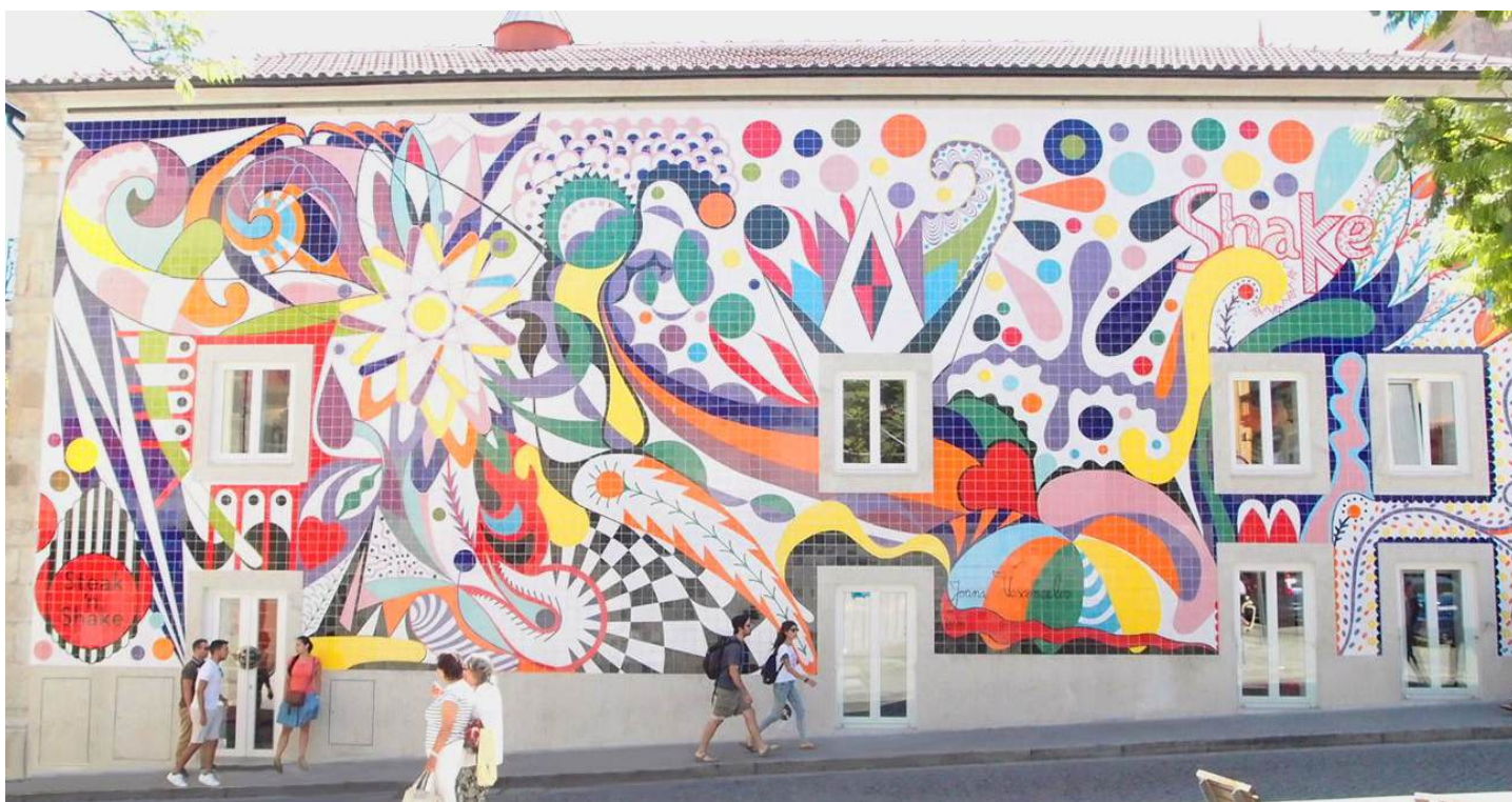
Reabilitação de fachada, Largo Moinho de Vento, Porto . autoria Joana Vasconcelos, pintura manual sobre azulejo 15x15cm. fotografia: Azulima
