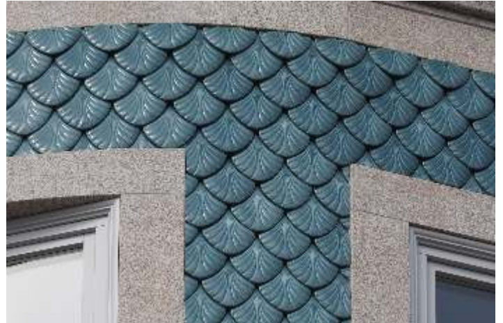
Reabilitação de fachada, Rua Mouzinho da Silveira + Lg. São Domingos , Porto . ref. AZ-R-soleto1
