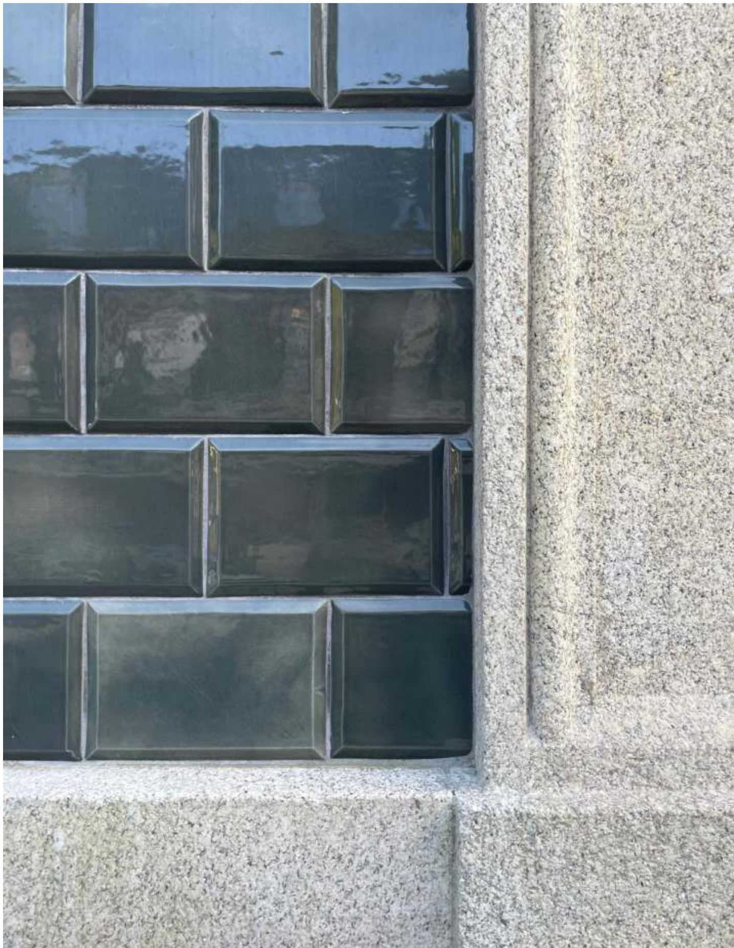
Reabilitação de fachada, Rua de Cedofeita, Porto . AZ-R-FX 4 (12,2x18,2cm) fotografia: Azulima
